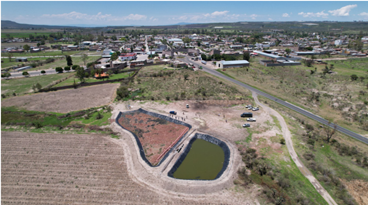
Figura 11. Sistema de tratamiento completo mediante HASS en SDA.
